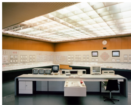
Stefan Oláh, Atomkraftwerk Zwentendorf, Niederösterreich, 1973, Siemens-Konsortium
