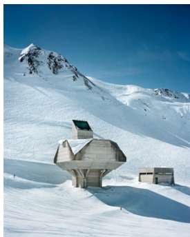
Stefan Oláh, Lüftungs- und Schachtkopfbauten, Arlberg-Tunnel, Tirol/ Vorarlberg, 1978, Hubert Prachensky, Ernst Heiss und Ernst Lackner
