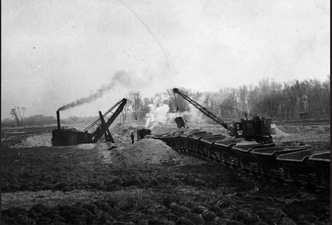
Lobau, Erdarbeiten und Aushub für einen Graben zur Grund- wasserabfuhr; der Materialtransport erfolgte auf den offe- nen Loren einer Feld- bahn (Februar 1941)
