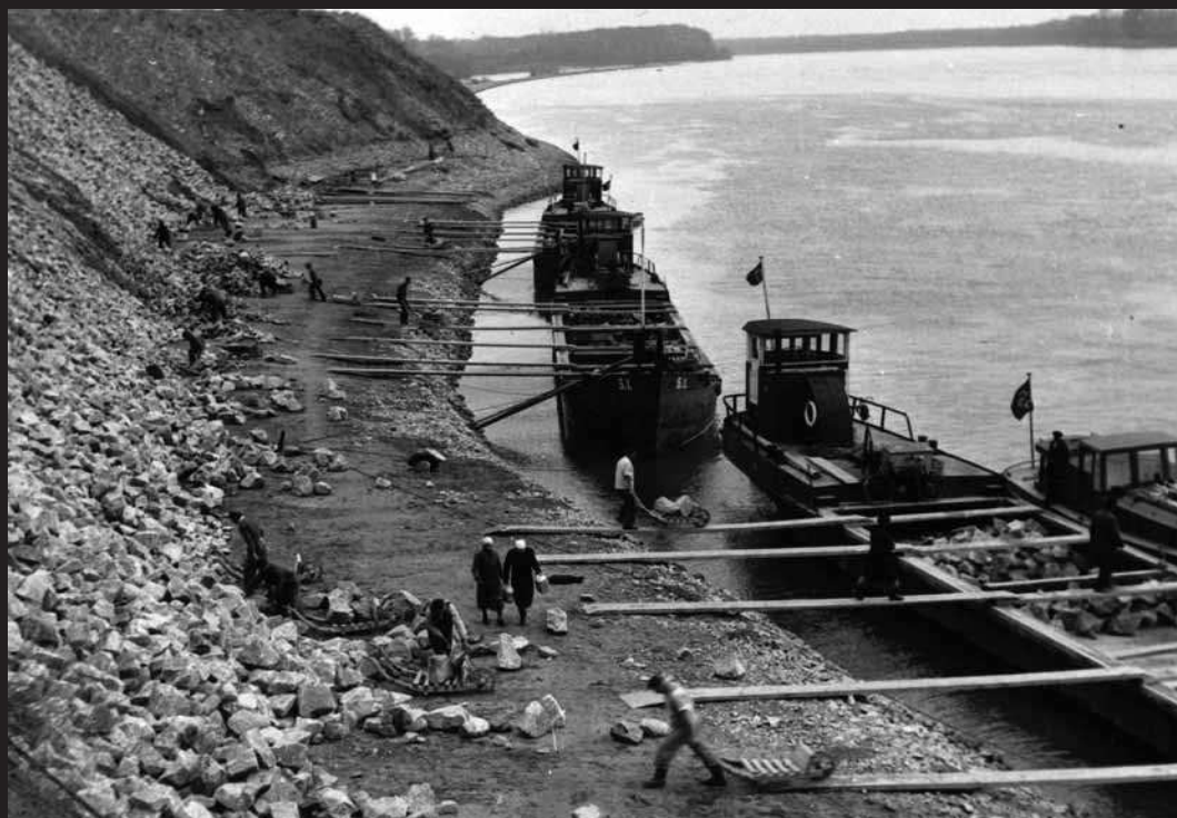
Lobau, Zwangsarbeiter befestigen die Uferböschung mit Schüttsteinen; Blick vom unteren Hafende Richtung Donau (Sommer 1942)
