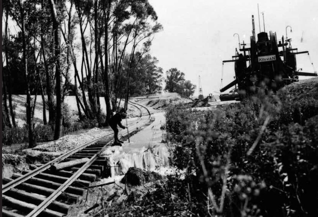
Lobau, Eimerketten-Schwimmbagger Krivan beim Durchstich des Marchfeldschuttdamms (= Hubertusdamm) zur Flutung des Hafenkanales (September 1941)
