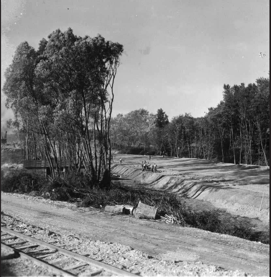
Albern, Blick auf die Baustelle der nicht fertig gestellten Hafenerweiterung im Augebiet am rechten Donauufer (Sommer 1941)
