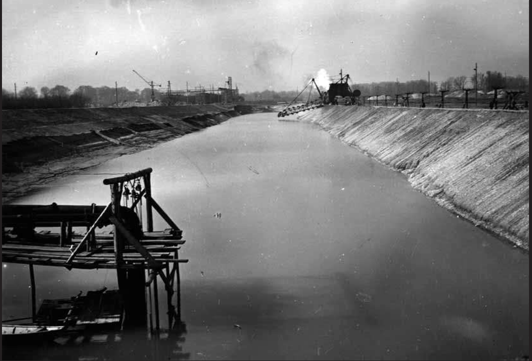
Lobau, im Hintergrund links die Baustelle des Großtanklagers der Wirtschaftlichen Forschungsgesellschaft mbH Berlin ( WIFO-Anlage ), rechts Böschungsausbau durch einen Elektrobagger, im Vordergrund eine Hafensperrung (März 1941)
