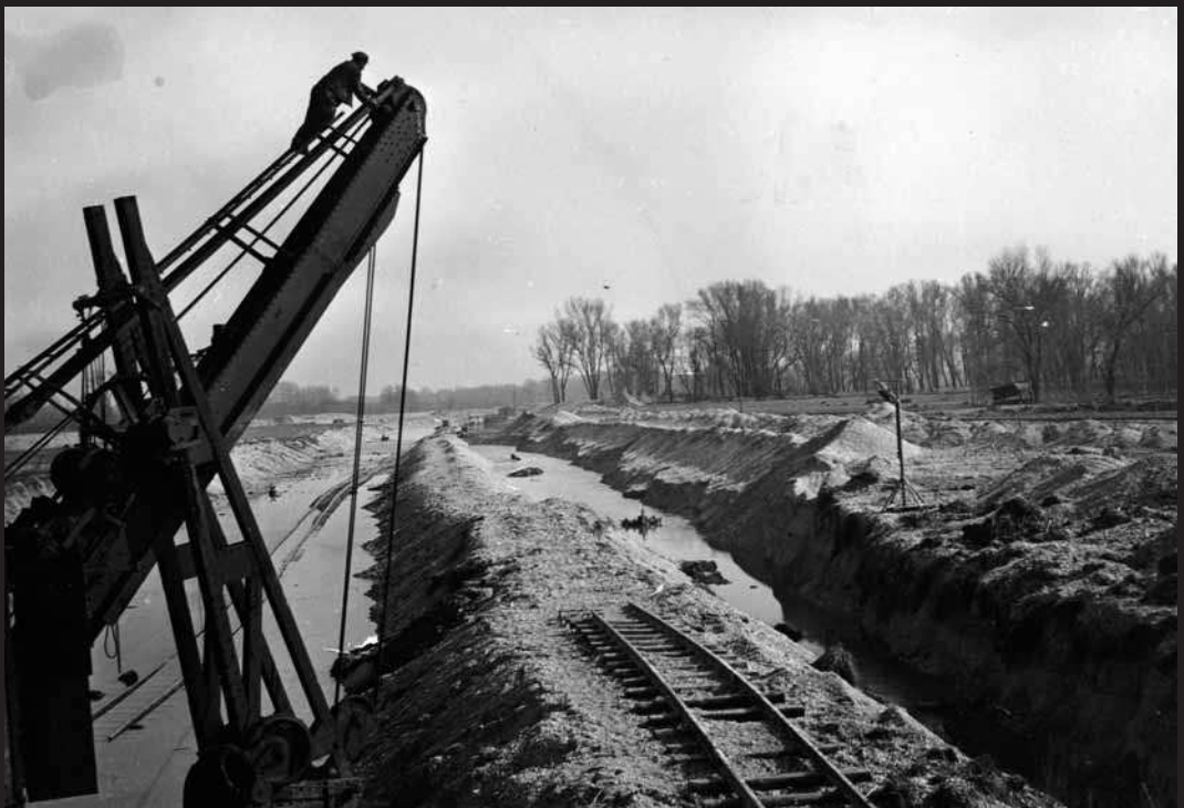
Lobau, Hochwasser- einbruch während der Planierarbeiten beim Bau des Hafenskanals (März 1941)
