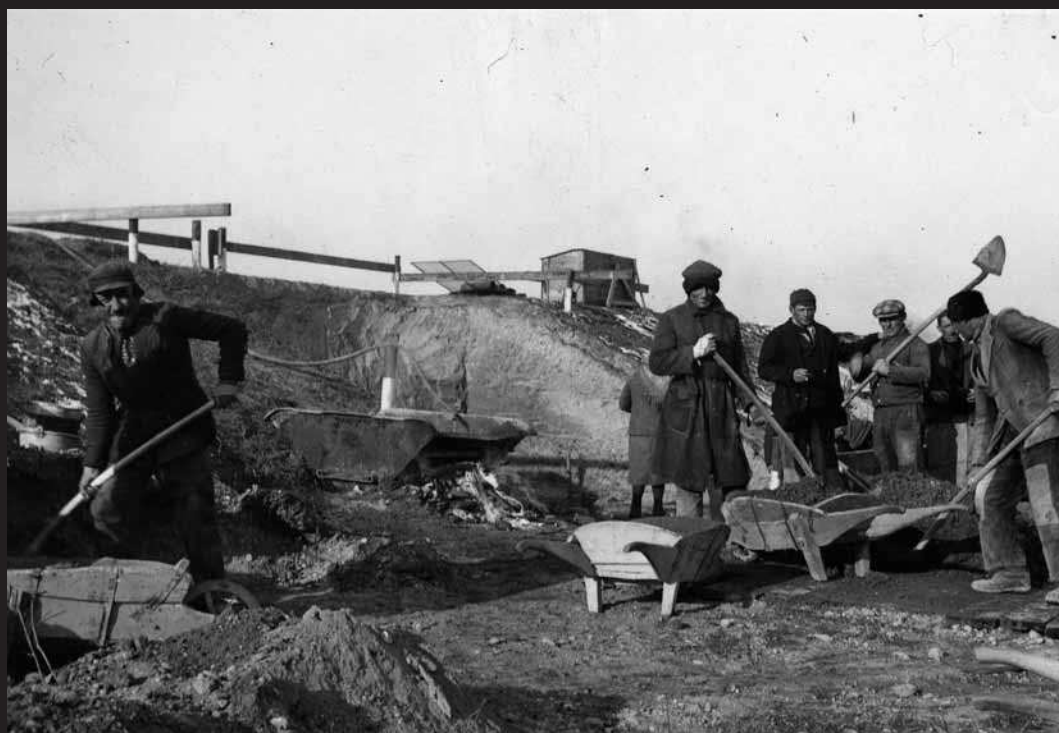
Lobau, Bau eines Beobachtungsturms am Rückstaudamm für den Luftschutz des Hafens (Dezember 1942)
