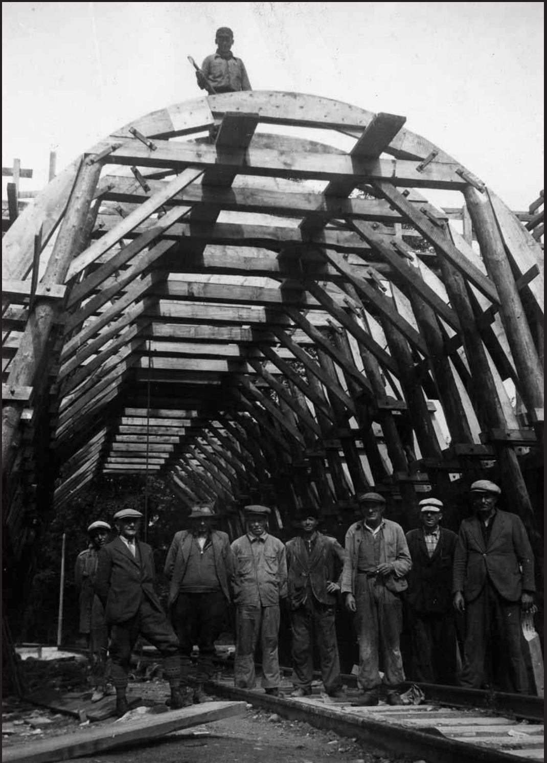
Lobau, Bau eines Luftschutzbunkers des Typs Salzgitter in der Lobgrundstraße (Sommer 1941)
